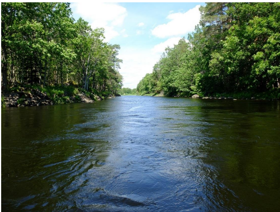
Figur 43. Upströms Vrängenacken, en kanalliknande sträcka upp till Karlshammars kraftverk som sänkts och rensats. Mycket berghällar längs sidorna och högar med rensmaterial. Större strukturer som block och hällar ute i åfåran har förmodligen sprängts bort helt vid rensningen.
