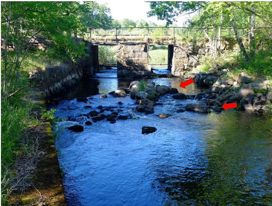
Figur 17. Passagen under bron kan förbättras om höljan nedanför höjs något. Stenar från den norra sidan sprids ut på strömnacken och en lekbotten för laxfisk läggs ut i området framför och upp på strömnacken så denna höjs. Därmed minskar fallhöjden under bron samtidigt som en lekplats skapas.
