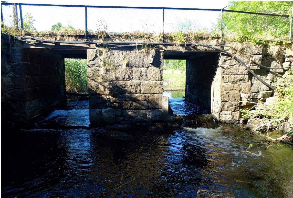
Figur 16. Bron till det gamla pappersbruket är stensatt med två valv. Passagen utgör ett partiellt vandringshinder.
