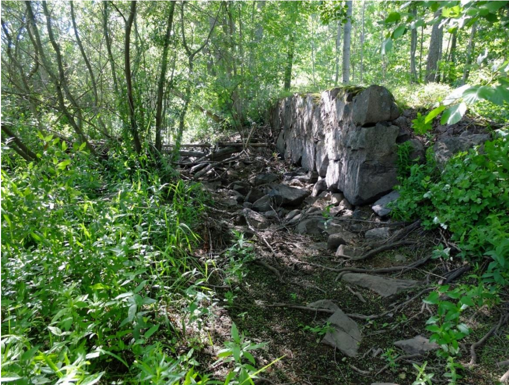
Figur 8. I området finns flera vackra kallmurade stenmurar uppbyggda, vilka sparas och i viss mån repareras där nerrasade stenar kan lyftas tillbaka i samband med biotopvården.
