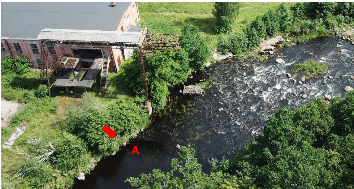
Figur 33. Åtgärdslokal 3F, omfattar strömsträckans övre del där en fin strömnacke finns vilket är en bra plats att sprida ut leksten och skapa ett större lek område för laxfisk (A). Platsen är mycket lättåtkomlig från bruksområdet där en bandgående grävmaskin kan sprida ut materialet i området.
