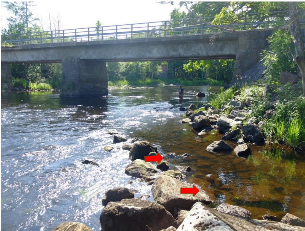
Figur 6. Inloppet till kvillen med upplagda block framför som föreslås att sänkas något. Blocken glesas ut och en del flyttas in till norra sidan så att mera vatten kan rinna in vid lågflöden.
