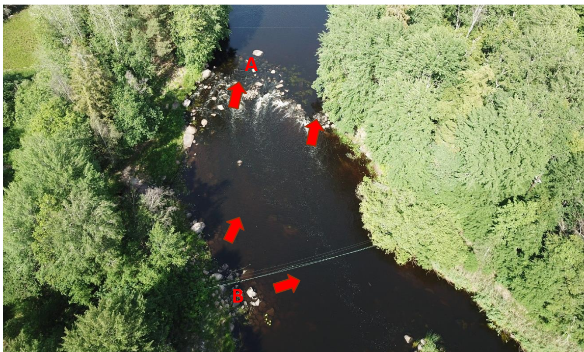
Figur 34. Den översta av strömnackarna i Emsforsområdet. Man kan sprida ut sten- och blockmaterial ytterligare samt etablera lekkottar men åtgärden ges en lägre prioritet. Det finns några enstaka uppensade stenhögar ute i strömmen och utmed den östra stranden som kan spridas ut (A). Nedströms strömnacken finns ett litet område med större block som ligger i kanten (B) vilka kan spridas ut i strömmen, framförallt plockas block innanför de yttersta så att vattnet kan rinna in emellan. Arbetet sker i samband med åtgärd på lokal 3C och 3D,
