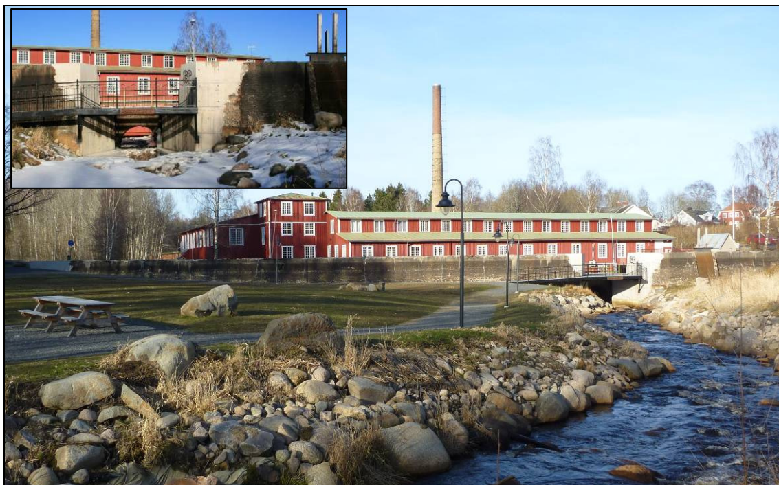
Figur 14. Utrivningen av Färgeridammen, Habo kommun.
