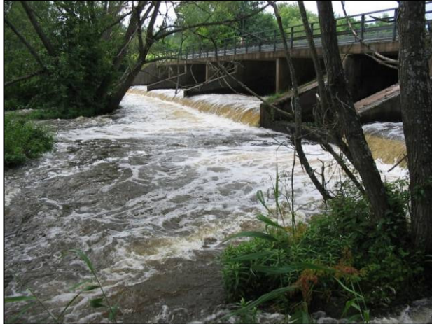
Figur 4. Exempel på ett stryk nedan hindret, sett från sidorna, före (t.v.) och efter åtgärd (t.h.), Vriggebodammen, Tranås. En 0,5 till 0,8 m hög bakkant på dammen har byggts bort genom att botten har höjts.
