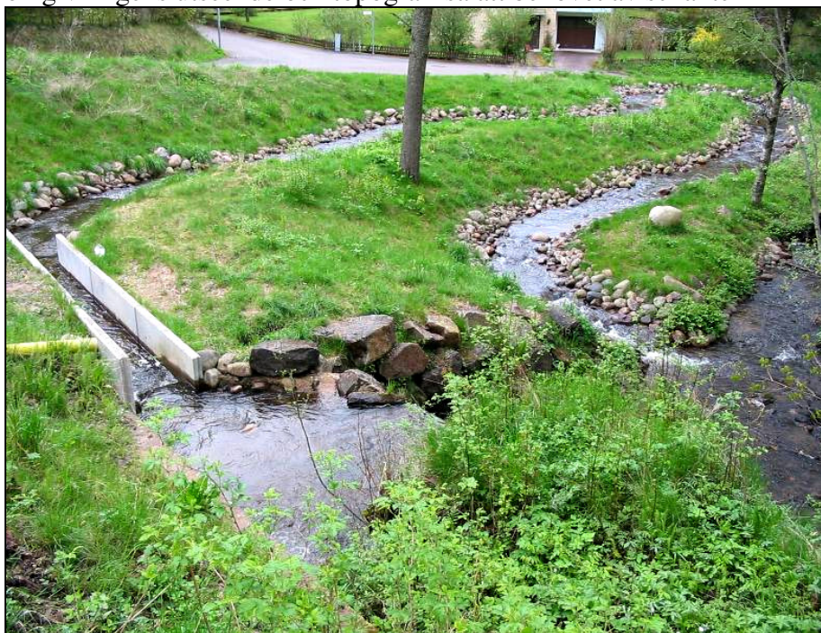
Figur 6. Exempel på omlöp som byggs runt hindret/dammen vid Åsafors i Kallebäcken, Jönköpings kommun.
