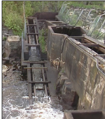
Figur 7. En bassängtrappa från Karlshammar i Emån (t.v.) och en Denilränna från Hertting (t.h.), Ätran.
