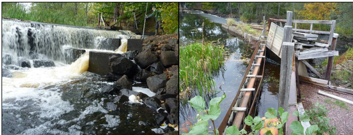
Figur 11. Dagens bassängtrappa är att betrakta som mycket svårforcerad (t.v.). En ombyggnation av kvarnutschovet har påbörjats, men inte avslutats (t.h.).
