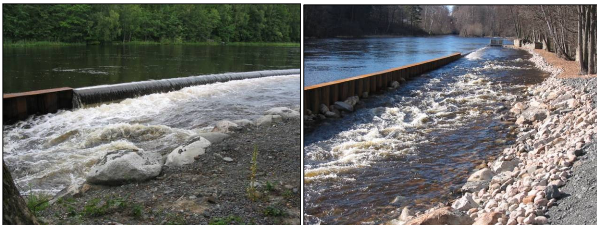
Figur 5. Exempel på fiskväg som byggs upp i dammen, från Hemsjö övre (t.v.) samt nedre (t.h.) i Mörrumsån.
