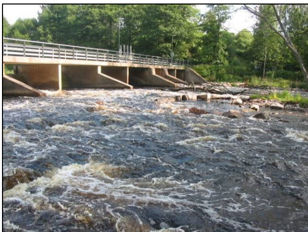
Figur 4. Exempel på ett stryk nedan hindret, sett från sidorna, före (t.v.) och efter åtgärd (t.h.), Vriggebodammen, Tranås. En 0,5 till 0,8 m hög bakkant på dammen har byggts bort genom att botten har höjts.
