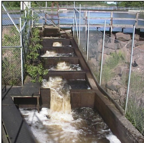
Figur 7. En bassängtrappa från Karlshammar i Emån (t.v.) och en Denilränna från Hertting (t.h.), Ätran.
