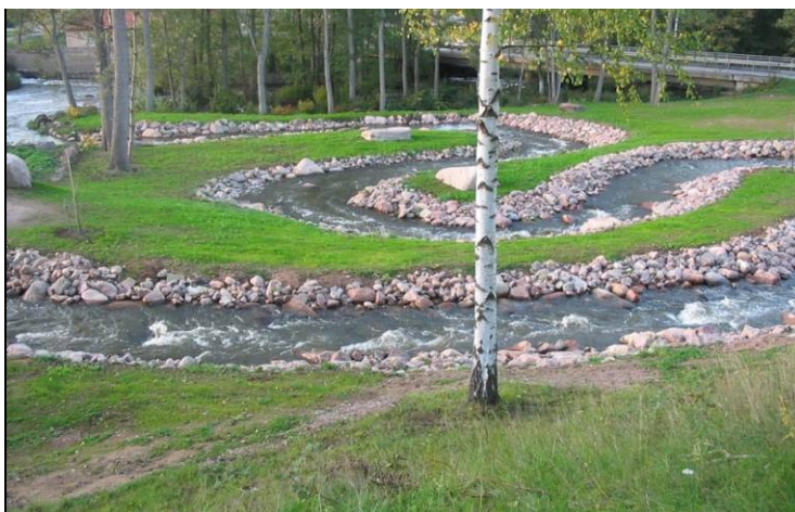
Figur 16. Exempel på ett omlöp i Åsvallehult i Tranås. Omlöpet utformades för att bli en trevlig parkmiljö.
