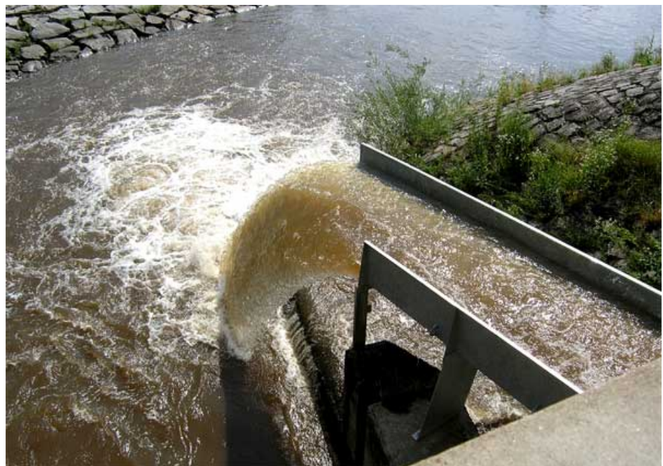
Figur 6. Exempel på fiskväg för enbart nedvandrande fisk i form av en, s.k. fallränna, från Steinach kraftverk vid Kinzig i Tyskland
