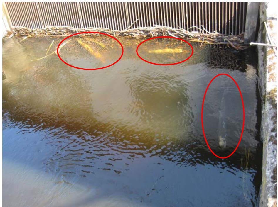
Figur 9. Nedvandrande utlekt havsöring vid Ugerups mölla i Vramsån som fördröjts p.g.a. felaktigt utformade och placerade flyktöppningar och därigenom drabbats av svamp, utmattning och svält. Efter ett par veckor framför gallret har de flesta omkommet.
