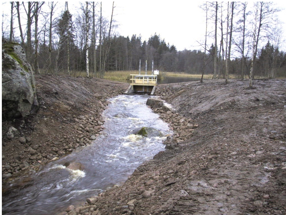
Figur 3. Exempel på en nyanlagd naturliknande fiskväg i form av ett s.k. omlöp, från Finsjö övre kraftverk vid Emån.
