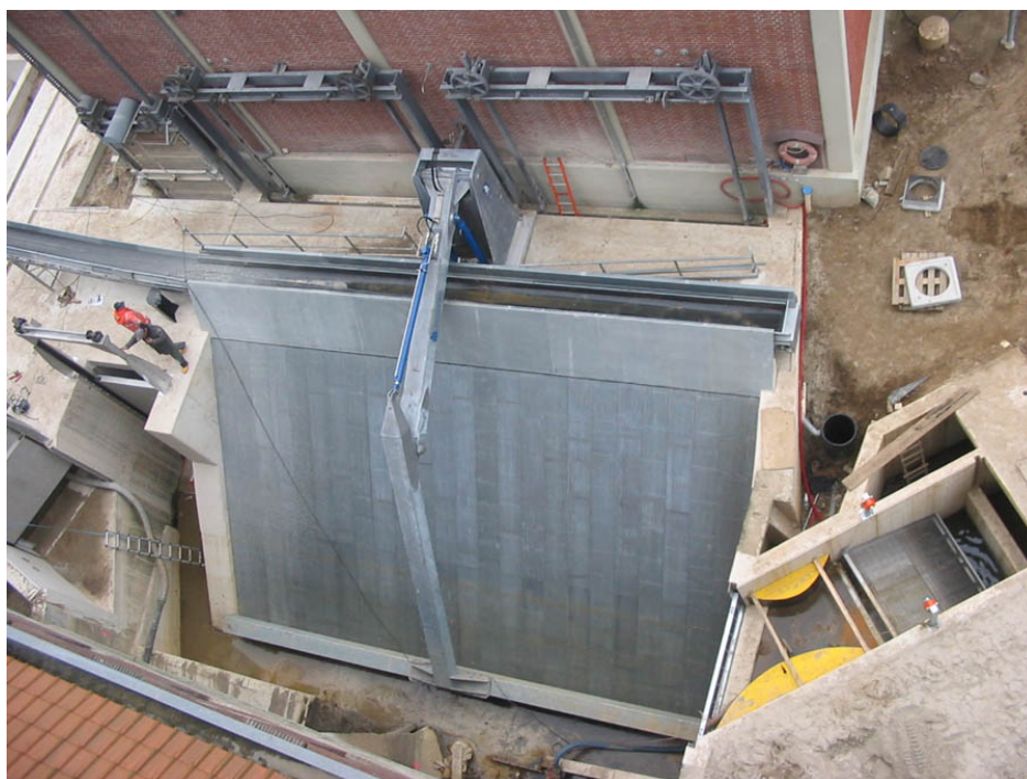
Figur 8. Exempel på lutande tvärställt fiskgaller med 10 mm spaltvidd, rensautomat och två flyktöppningar mot bakomliggande fallrännor för nedvandring vid ECI Centrale i Roermond vid floden Roer.
