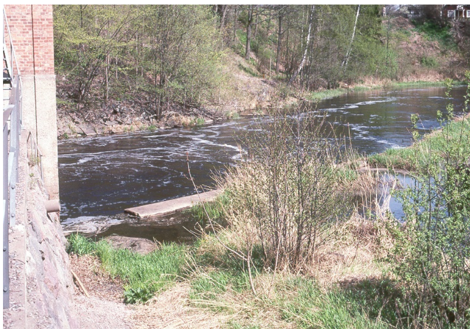
Figur 11. Åfåran nedanför kraftstationen är rensad och fördjupad. Till utloppskanal fördjupad åfåra nedanför kraftstationen. Vid vattenområdets hitre strand skimtar stödmuren som utgör gräns mot torråfåran. Foto från kraftstationen mot nordost, vattenflöde 28,8 m 3 /s.
