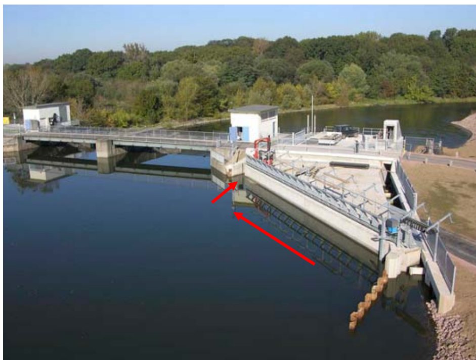
Figur 23. Exempel på snedställt fiskgaller med horisontellt löpande grindrensare från Planena kraftverk vid floden Saale. En flyktöppning med tillhörande fallränna är placerad mitt i bilden.
