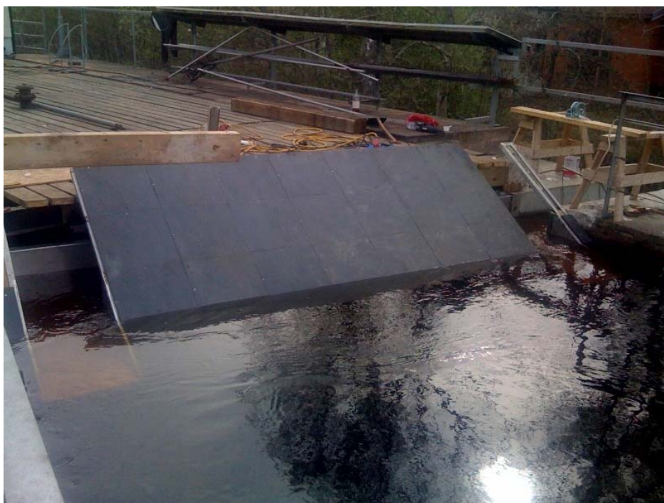
Figur 29. Exempel på flyktöppningar i övre delen av ett tvärställt lutande fiskgaller från Finsjö övre kraftverk, Emån. Bakom flyktöppningarna löper en tvärgående förbindelseränna som ansluter till en fallränna på utsidan en öppning i inloppskanalens sidovägg.
