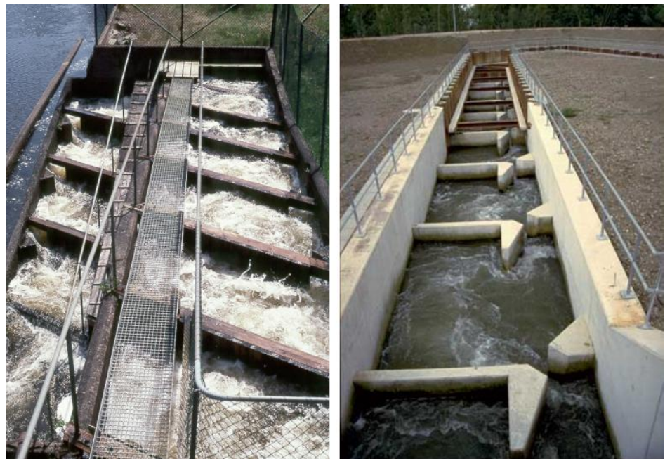
Figur 5. Exempel på en teknisk fiskväg i form av en s.k. slitsränna från Mariebergs kraftverk vid Mörrumsån (vänster) och Iffezheim damm vid floden Rhen (höger). Bilderna visar olika utformning av tvärväggar och de vertikala slitsformade öppningarna i dessa.
