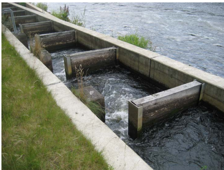
Figur 22. Exempel på slitsränna med 15 cm språnghöjd mellan bassängerna från Marklendorf vid floden Aller.
