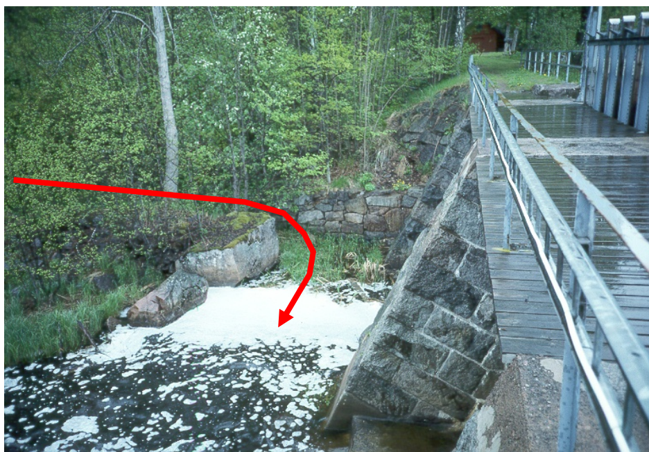
Figur 20. Regleringsdammens västra landfäste. Läget för den föreslagna fiskvägens utlopp är markerat med röd pil. Vy från dammbyggnaden mot väst.
