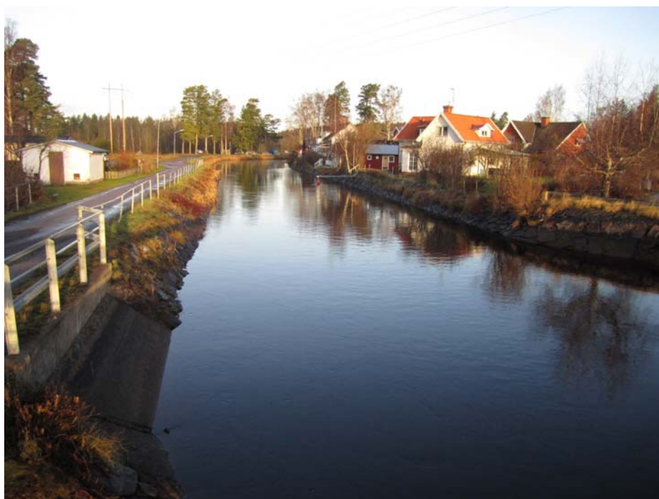
Figur 10. Inloppskanalen, vy från landsvägsbron mot norr.
