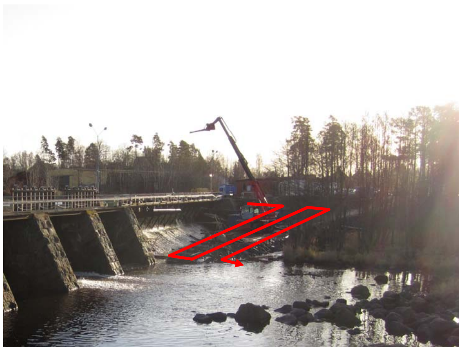
Figur 21. Föreslagen placering av slitsränna vid dammbyggnadens vänstra sida. Vy från dammbyggnadens högra landfäste mot sydost.
