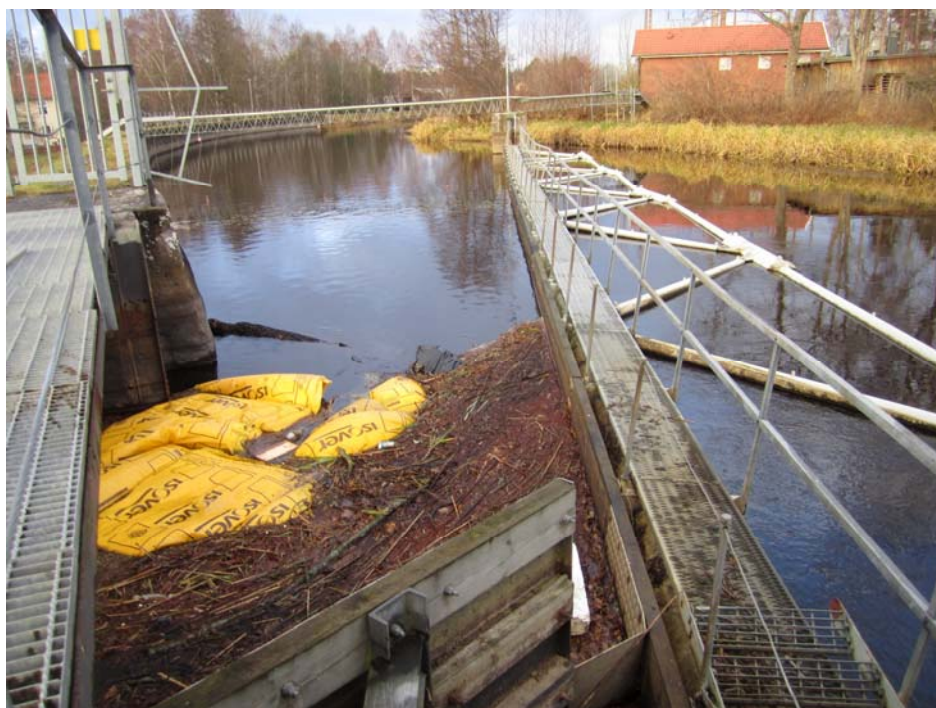
Figur 15. Inloppskanalen och flytlänsan. Vy från inloppskanals högra sida nedan isutskovet mot isutskovet mot väster.
