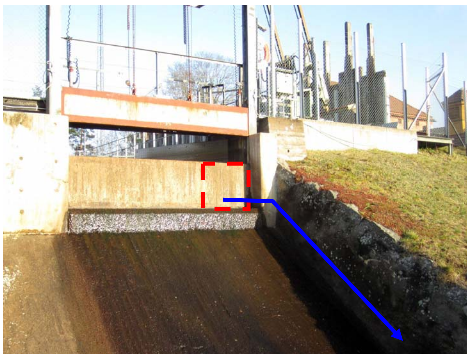
Figur 24. Placering av flyktöppningen i rött och fallrännan i blått i befintligt isutskov.
