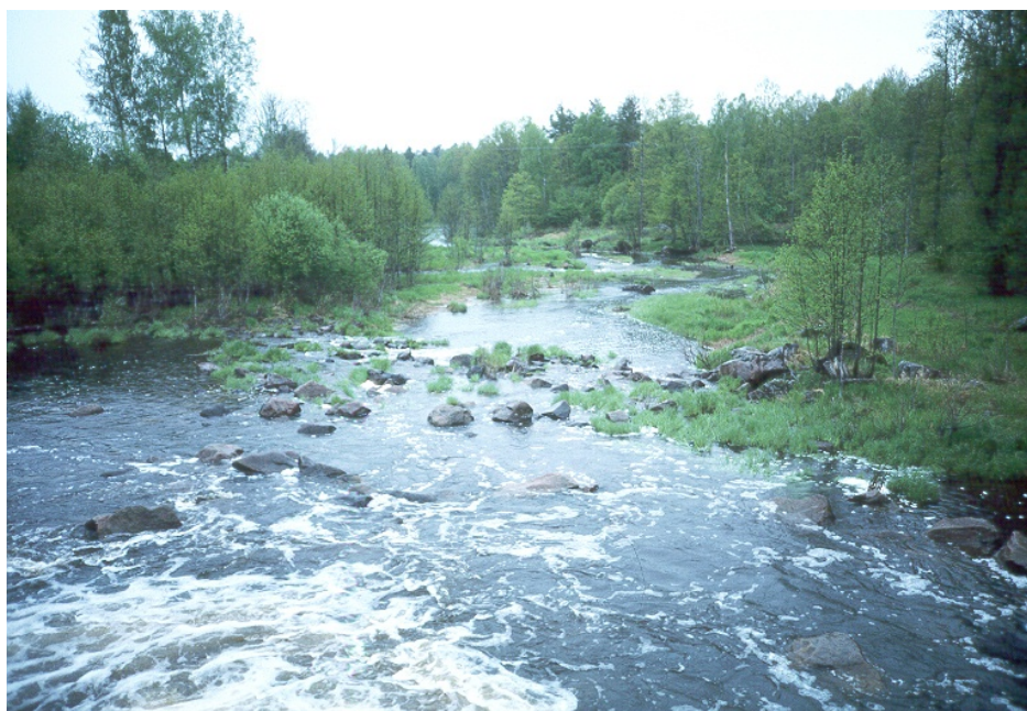
Figur 18. Emåns normalt torrlagda naturliga åfåra vid tappning av ca 3,2 m 3 /s. För att skapa bra vandringsvägar kan viss tillrättläggning av block på de grunda trösklarna krävas. Foto från regleringsdammen mot sydväst.
