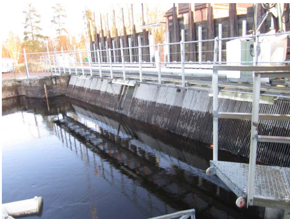
Figur 16. Befintlig gallergrind. Vy från isutskovet mot nordost.
