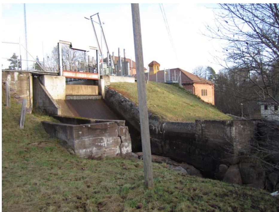
Figur 14. Isutskovet med tillhörande planlucka av betong samt utloppsränna. Vy mot nordost.
