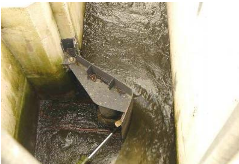
Figur 25. Exempel på en i sidled justerbar regleringslucka i övergången mellan en flyktöppning och en fallränna för nedströms vandrande fisk vid Planena kraftverk i floden Saale.
