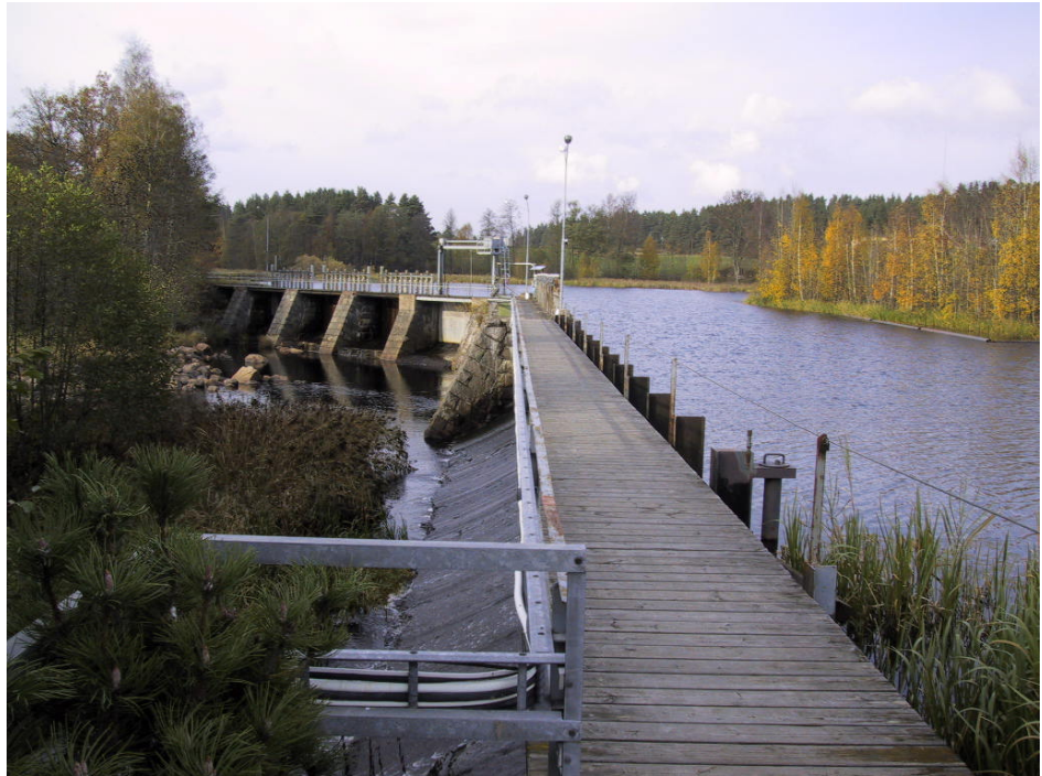
Figur 12. Dambyggnad med luckor tvärs över den naturliga åfåran. Foto från östra landfästet mot nordväst.
